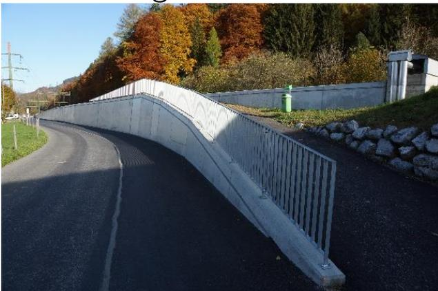
Der Abschnitt ist Bestandteil des Gesamtkonzepts Hochwasserschutz Bödéli. Auf einer Länge von rund 1.2 km wurde das linke Ufer der Lütschine erhöht und verstärkt. Dies wurde im oberen Projektabschnitt mit dem Ersatz der bestehenden Dämme durch eine robuste Be-
