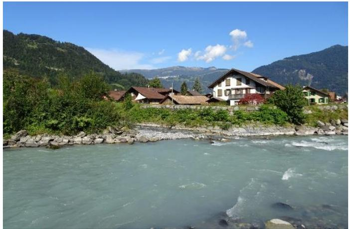
Der neue Hochwasserschutzdamm wurde überströmsicher ausgeführt, indem auch die luftseitige Dammböschung mit überschütteten Blöcken gegen Erosion gesichert wurde.
