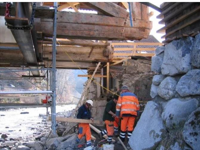
Mit rund 170 m<sup>3</sup>/s lag die Abflusskapazität der Lüttschine im Bereich der Holzbrücke Gsteig weit unter dem für die Hochwassersicherheit erforderlichen Wert. Um den Engpass zu entfernen, wurde die Brücke mit einem hydraulischen
